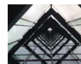
重力換気シャフトを見える化した「コーナーボイド」
